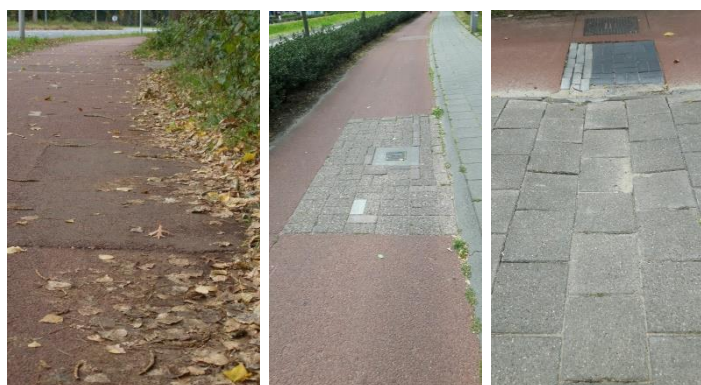
Figuur 1. Fietspad langs Rooseveltweg. Links na opbreking weer geasfalteerd, dit stuk heeft een redelijke kwaliteit; midden een recente opbreking en met klinkers weer hobbelig dichtgelegd; rechts een bedroevende kwaliteit bestrating van zowel fiets- als voetpad.
